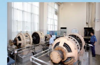
勝鬨橋を動かしていた発電設備
