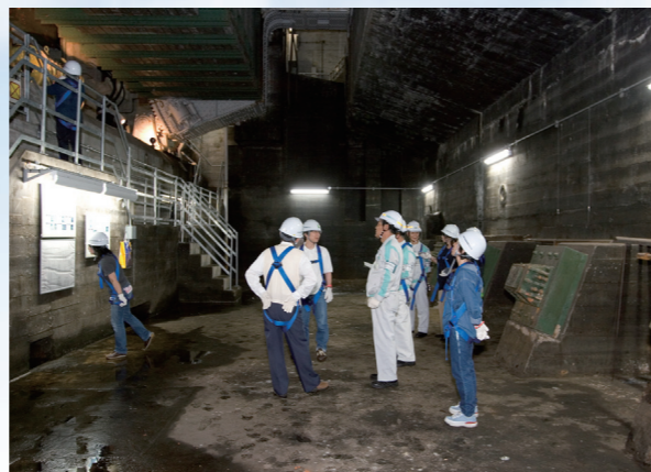
橋脚内での見学の様子。広さはテニスコート約1面、高さ9mという巨大な空間です。
