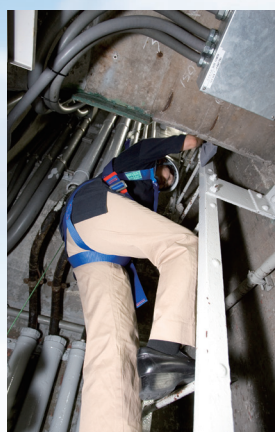
ハーネスを装着し、高さ 3.5m の橋脚内の梯子を垂直に降ります。
