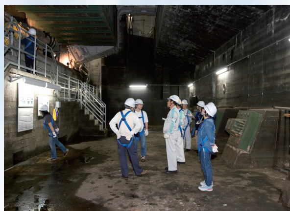
橋脚内での見学の様子。広さはテニスコート約 1 面、高さ 9m という巨大な空間
