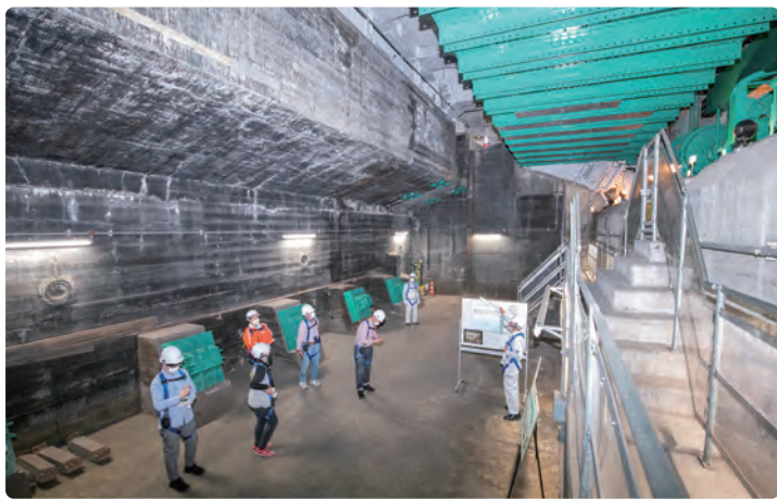
橋脚の中には巨大な空間が広がっています。
