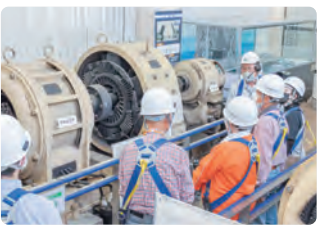
勝開橋を動かしていた変電設備も展示しています。
