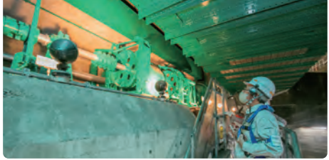
勝開橋を開閉していた動力部分
