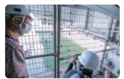
橋脚の中から隅田川を見ることが出来ます。
